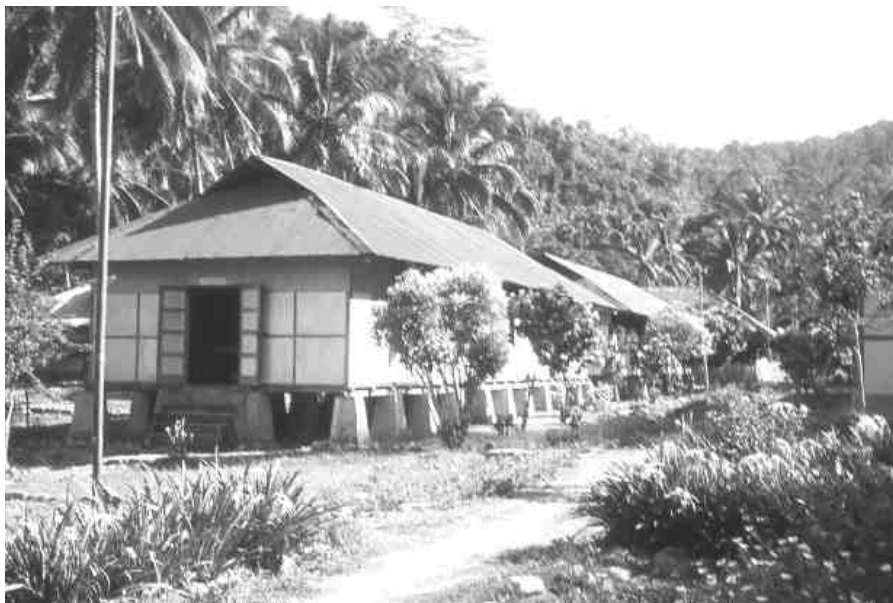
Sungai. Ashrama. Dormitorios.
