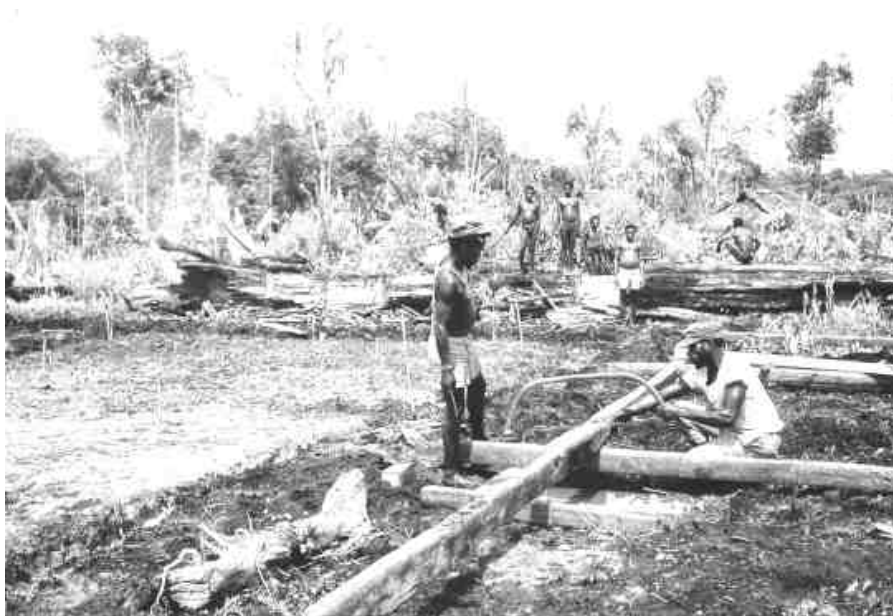
Guru Titus construyendo una vivienda en Merdei
